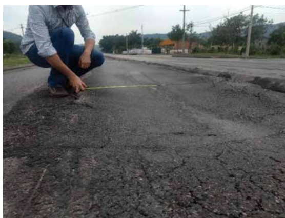
Exemplo de afundamento e/ou deformação com formação de trilha de roda
