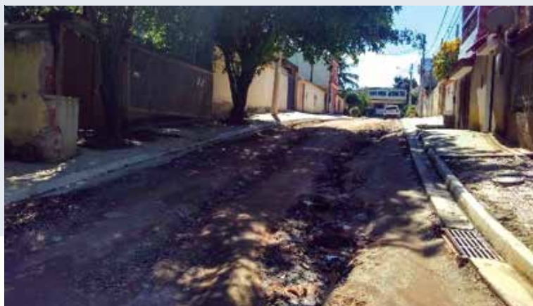
Erosão em camadas de pavimentação na Travessa Chico Mendes
