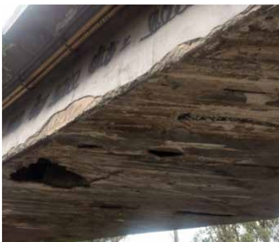
Tabuleiro inferior danificado no Viaduto Engenheiro Oscar Brito
