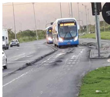
Afundamento de trilha de roda no entorno da estação Mato Alto
