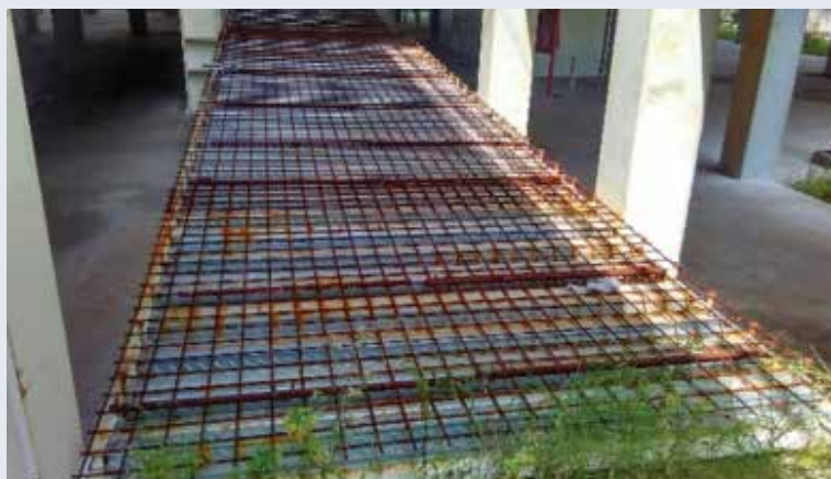
Armadura sob corrosão (estrutura de rampa inacabada) Campus Ana Neri
