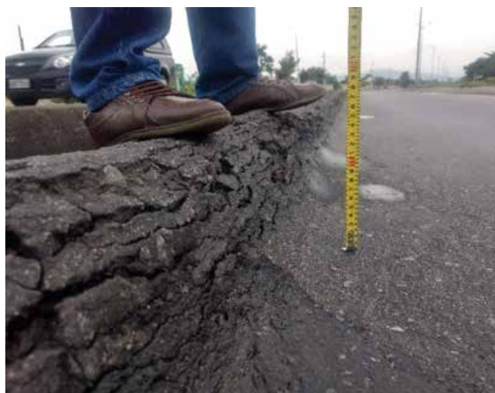
Ondulações de aproximadamente 15 cm em diversos pontos do corredor expresso
